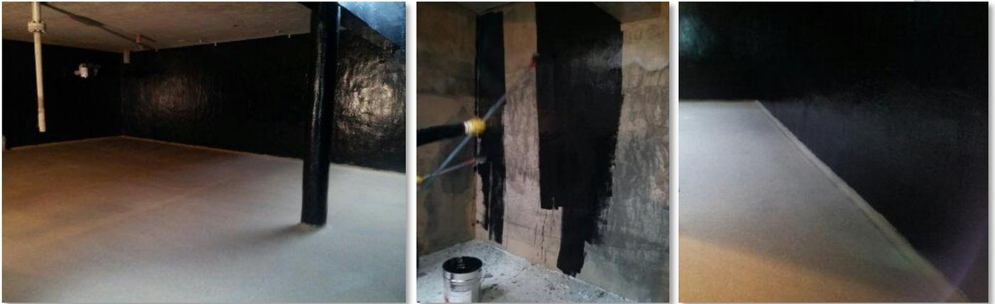
Als chemiefeste High-End-Beschichtung wurde auf allen Flächen **Proguard CN-1M** in einer Schicht per Rolle aufgetragen.
