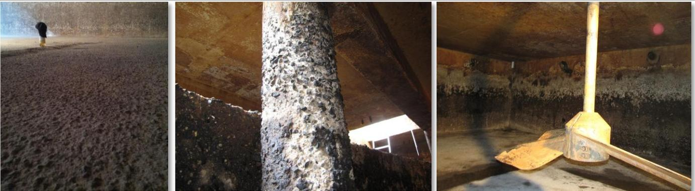
Der Speicher war aufgrund starker Betonauswaschungen, entstanden durch den chemischen Angriff der aggressiven Bioreststoffe, in einem maroden Zustand.
