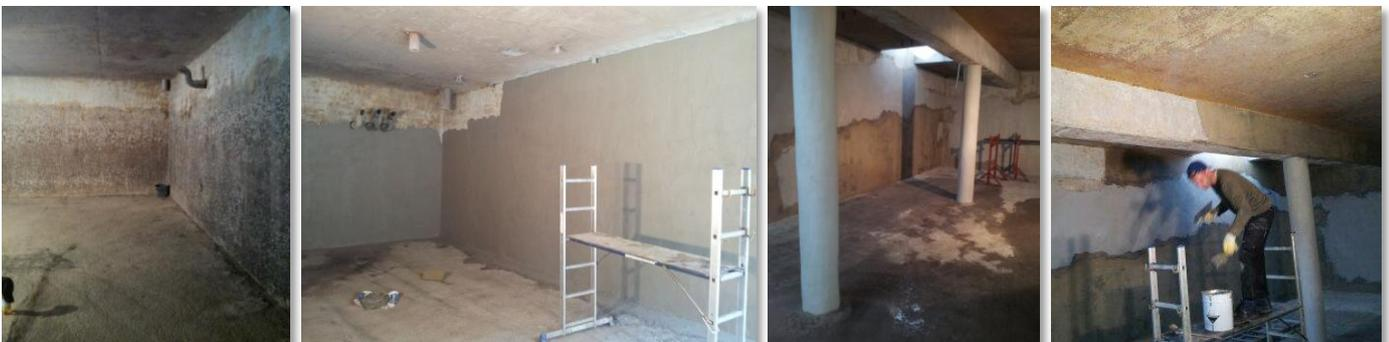
Die gesamte Fläche wurde zur Vorbereitung zunächst sandgestrahlt. Die Wände bekamen zudem eine hochwertige Vorgrundierung und Spachtelung. Auch die angegriffenen Betonpfosten wurden mit einem adäquaten Mörtelprodukt geglättet. Anschließend wurden die Wände mit unserem chemikalien- und abriebfesten Primer **CP-Synthofloor Beta 8016** grundiert.
